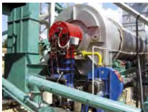
Горелка с воздушным распылением
