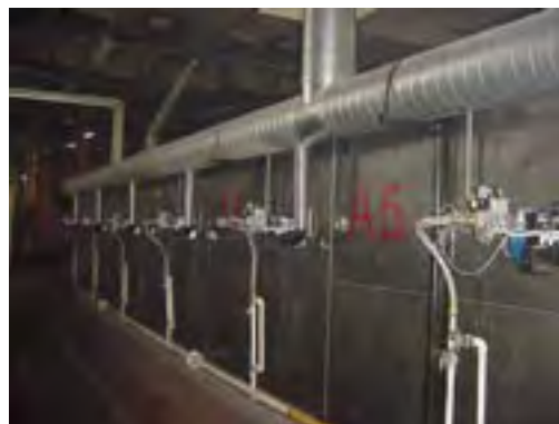
Термообрабатывающее оборудование стекольного завода
